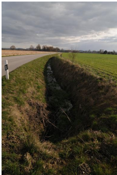
Abbildung 1-6: Graben nahe Eingriffsbereich (29.03.2016)
